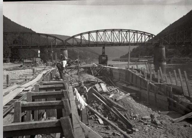
Neckarlauer – Instandsetzung Ufermauer
