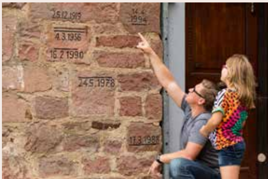
Oben: Beeindruckende Hochwassermarken an der Stadtmauer
