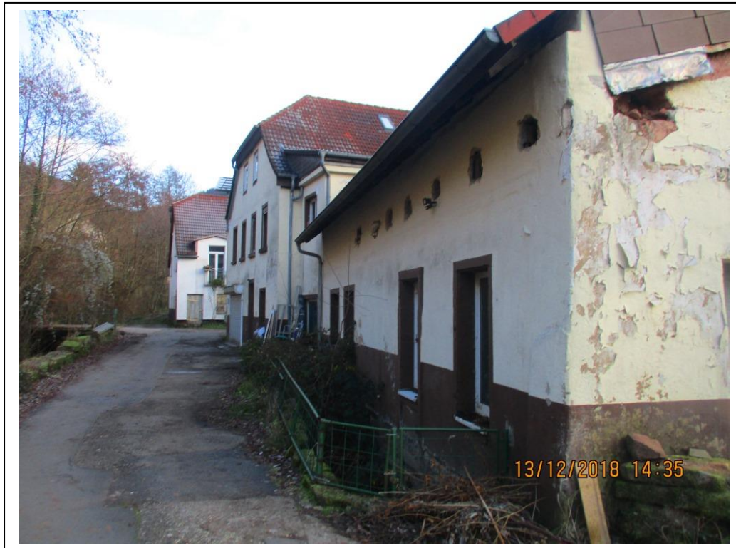
Abb. 3: Im Vordergrund rechts: das leerstehende Werkstattgebäude, dahinter die Wohnbebauung; am linken Bildrand noch zu erkennen: die Ufermauer des Holderbachs. Unter der Straße verläuft der Abwasserhauptsammler für den Stadtteil Holdergrund
